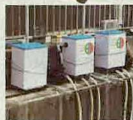
マイクロナノバブル発生装置(河川浄化用)
